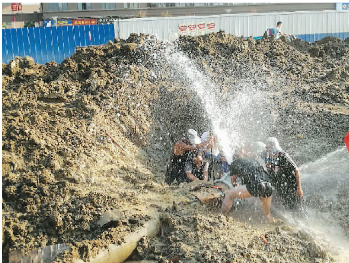
供水抢修现场
