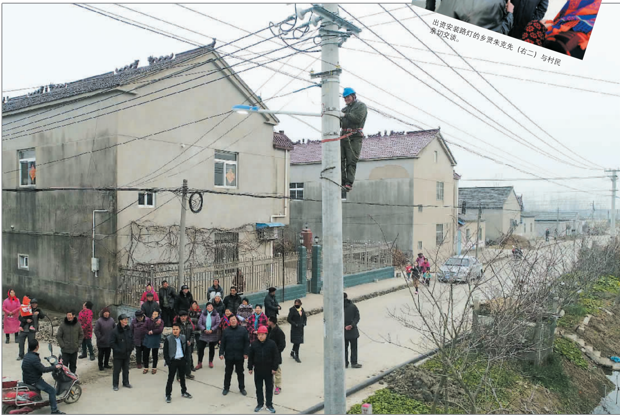
村民围观电工调试路灯
