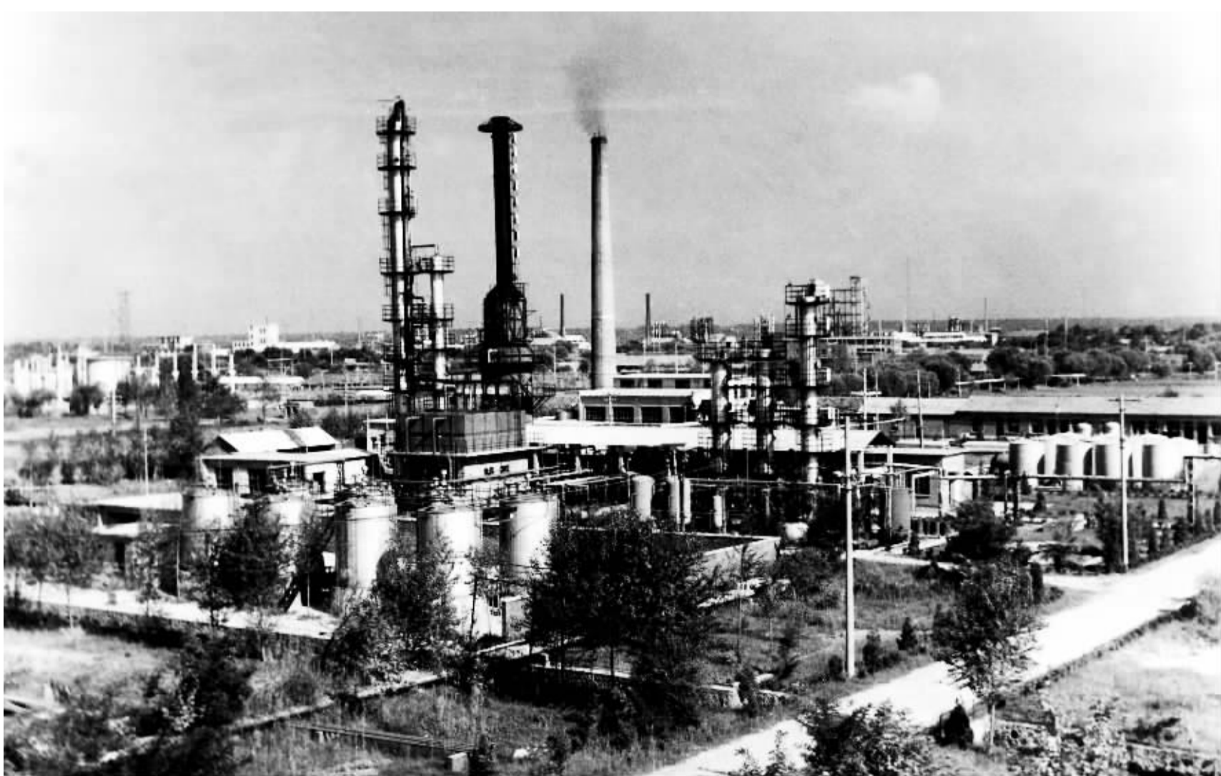
上世纪80年代初,炼油厂区常压蒸馏装置
