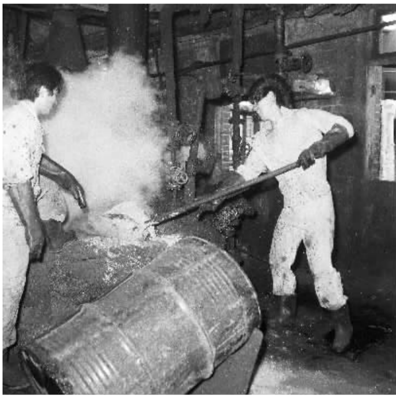
建厂初期,“两口大铁锅”土法炼煤焦油的手工作坊
