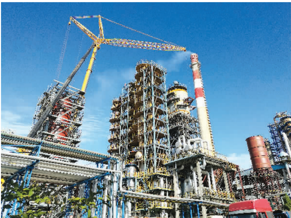
公司催化烟气脱硫脱硝除尘装置技改现场
