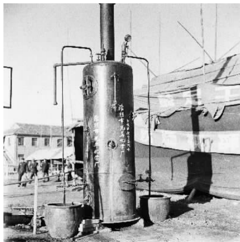
光华厂自制的喷气机锅炉
