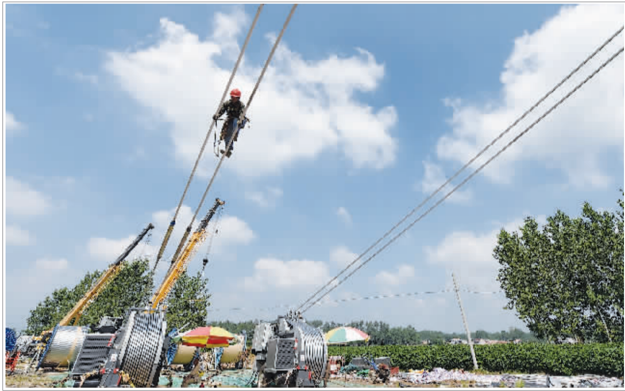
8月中旬,锡盟—泰州±800千伏特高压工程苏2标段进入放线阶段,施工人员抓住晴好天气,抢时间、赶进度,确保按期完成工程施工任务。图为8月23日,在涟水县五港镇境内,江苏省送变电公司施工人员正在施放导线。
