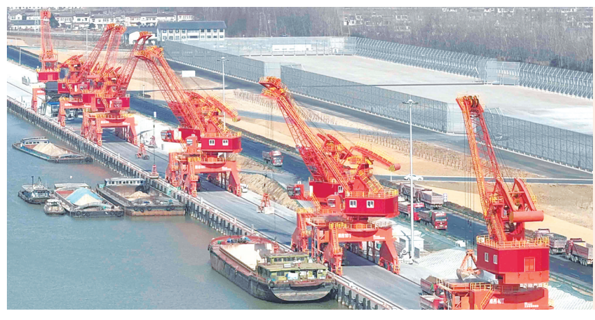
新年伊始,我市各港口货轮有序进出,各作业码头运输车辆往来穿梭,一派繁忙景象。图为1月8日拍摄的淮安山阳港作业区。
