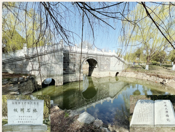
移建后的板闸火山岩石拱桥
