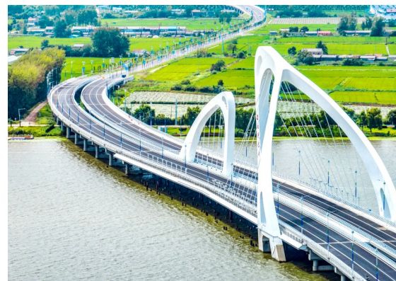
白马湖大桥是白马湖大道关键节点工程,这座大桥设计灵感来源于《辛氏三秦记》中的“鱼跃龙门”,跃湖而出的设计备受欢迎。目前,大桥已具备通车条件,即将交工验收。 ■张骏 贺敬华
