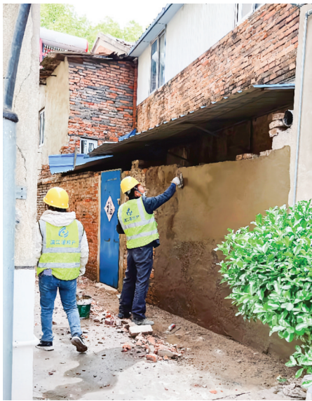
老旧小区改造现场
