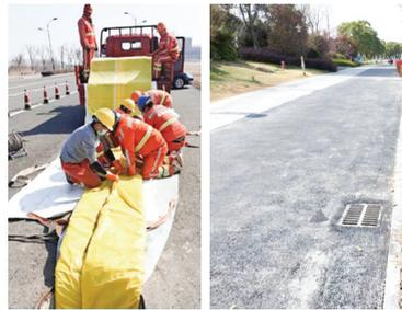
整个过程借助装有摄像头的灯架全程可视,实时查看施工作业效果和进度。该技术相比传统方法具有明显的优势,施工时间短、固化速度快,过程更加方便、更为高效地处置管道破裂问题,实现非开挖式修复,同时对周边环境没有污染损害,节省了大量的人力和物力,施工难度大大降低,施工效率极大提升。本次修复工程原定3个多月的工期,公司提前半个月完工。“别看这是‘微创手术’,修复效果可不差!”管理人员说。
