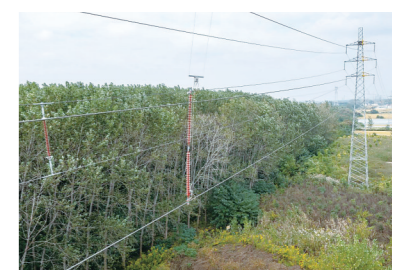
运载无人机将特制挂钩间隔棒安装在导线上
