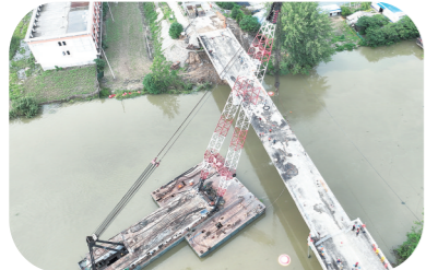
金宝航线淮安段航道整治工程石港大桥老桥拆除现场
