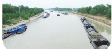
京杭运河淮安段绿色现代航运综合整治工程
