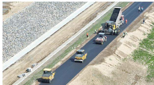
4月26日,环洪泽湖公路淮阴段项目建设现场,施工方正在铺设沥青。环洪泽湖公路全长170.87公里,将于5月上旬建成通车。
