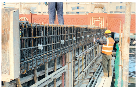
盖梁模板安装
