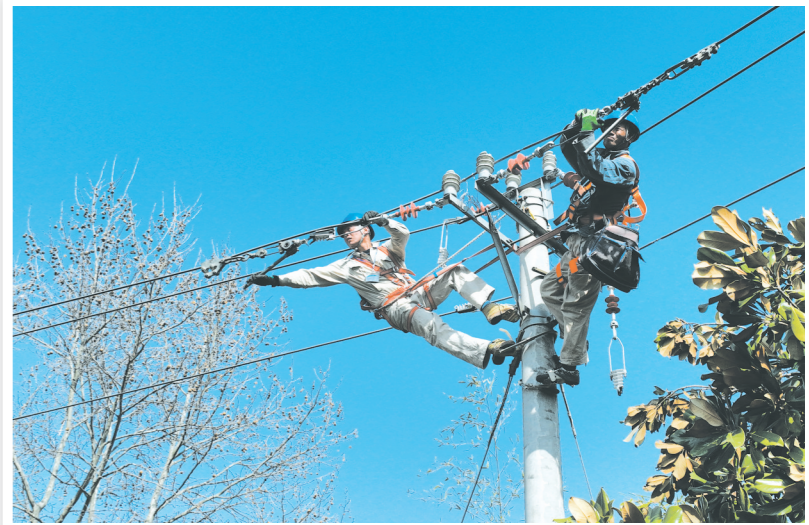
日前,在盱眙县4A级景区铁山寺国家森林公园,国网盱眙供电公司员工对10千伏铁山147线林场支线实施绝缘化升级改造。该支线长1.98千米,已运行28年。此次改造将原10米电杆更换为15米电杆,将原70平方毫米裸导线更换为150平方毫米绝缘线,提高景区供电保障水平,消除安全隐患。
