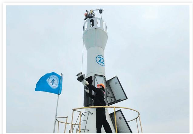
近日，洪泽区港航事业发展中心迅速行动，开展了一次全面的航道巡查，并着手更换老化的航道测深灯器，确保航道安全、畅通。
