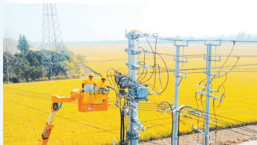
2023年10月31日,市供电公司通过带电作业更换一处农村破损导线,确保了附近村民秋收种正常用电。
