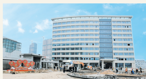
涟水县政府民生实事项目涟水县中医院二期工程内科楼即将完工
