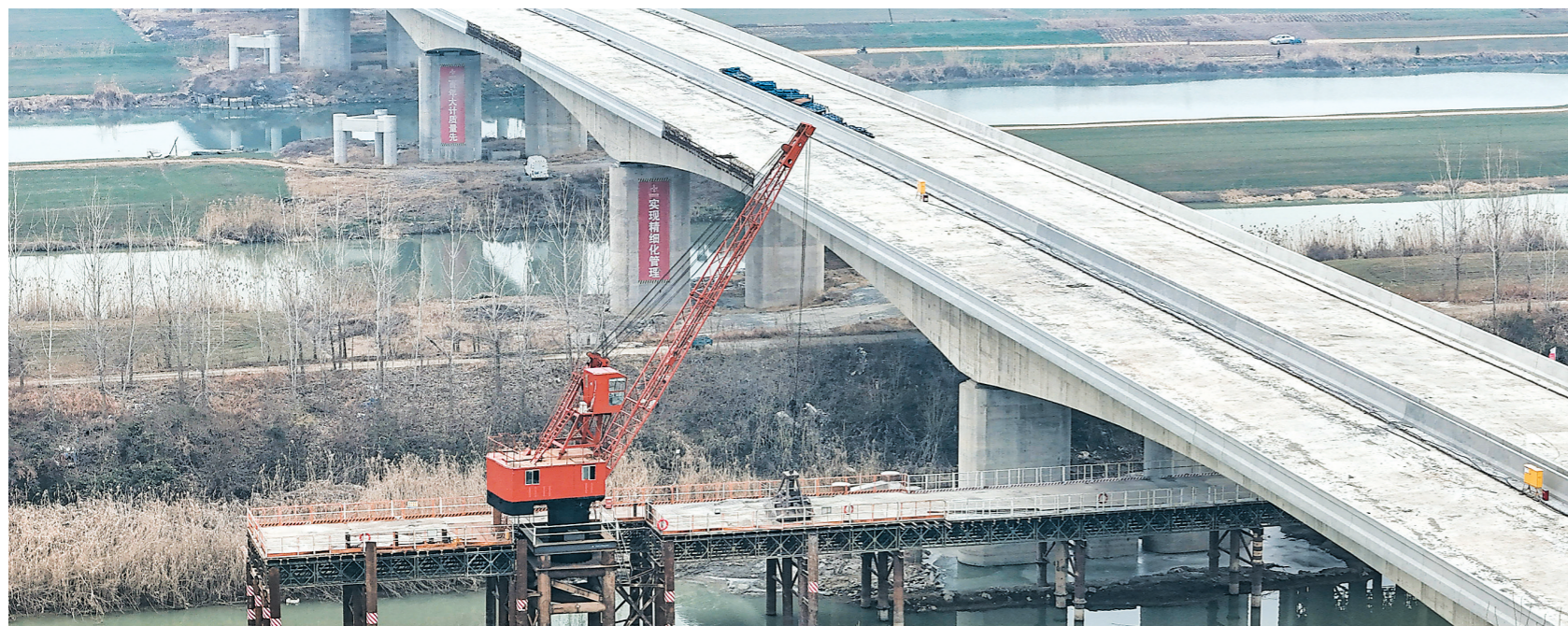
省道建设施工忙
