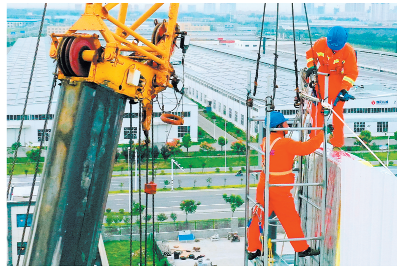
近日，在洪泽区华新新材料工业项目建设工地，建设者们坚守岗位忙施工，有序推进项目早日建成投产。 ■通讯员 崔德圣
