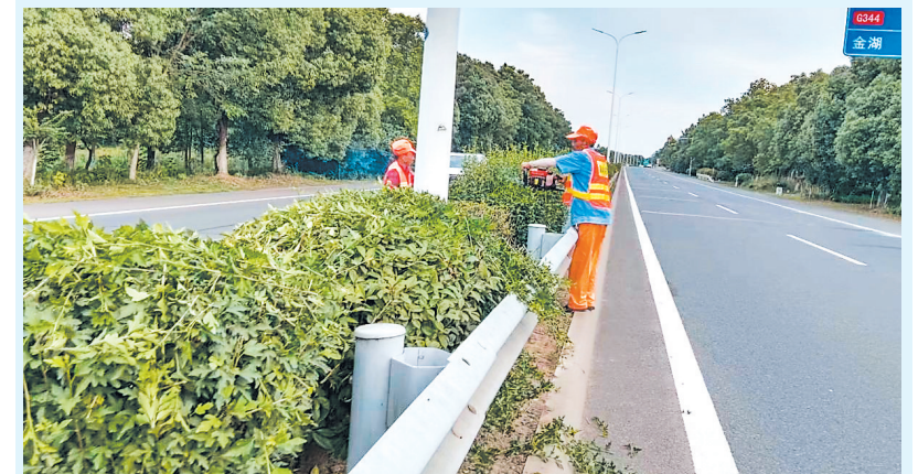
为提升群众出行舒适度,强化道路安全,近日,洪泽区公路事业发展中心紧抓公路绿化养护工作,安排养护工人对辖区干线公路绿化进行修剪。
