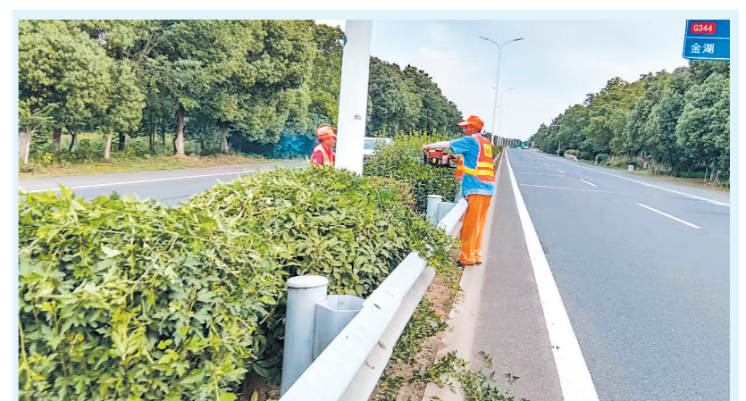
为提升群众出行舒适度,强化道路安全,近日,洪泽区公路事业发展中心紧抓公路绿化养护工作,安排养护工人对辖区干线公路绿化进行修剪。
