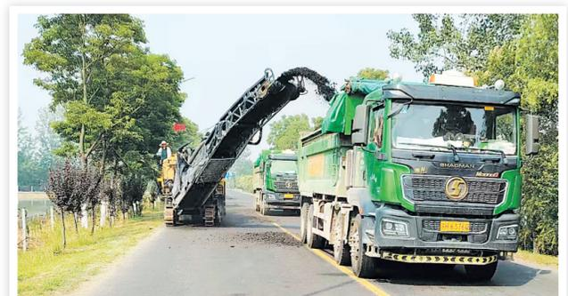
近日,由涟水丙辰工程养护有限公司中标承建的235省道涟水县今世缘大道东首至灌南县交界处大中修项目正式开工。该项目总长度为4.864千米,全幅路基病害铣刨,加铺32厘米水稳碎石基层和SUP-(13-20)沥青面层结构,总造价为1820余万元,预计9月底全部完工通车。
