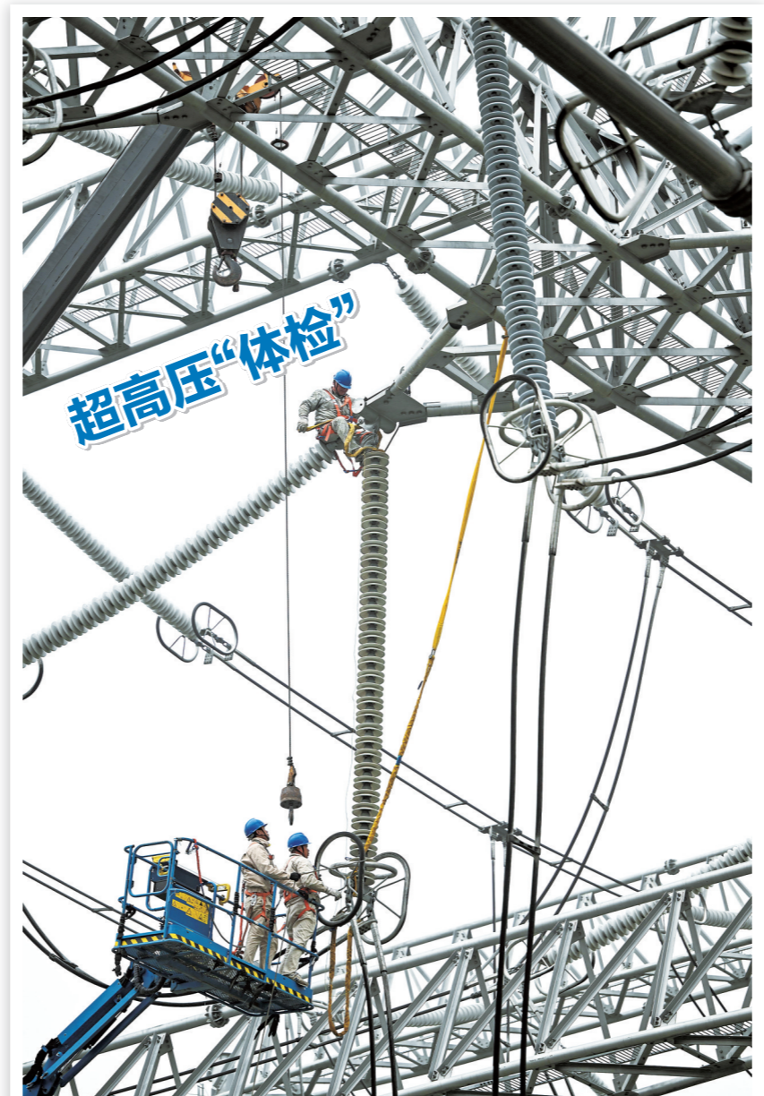
连日来,国网淮安供电公司技术人员对500千伏旗变开展春季检修工作,提升新能源送出能力,助力淮安经济高质量发展。图为3月23日,涟水县成集镇电力工人更换B相绝缘子串。 ■通讯员 梁德斌 王秋生
