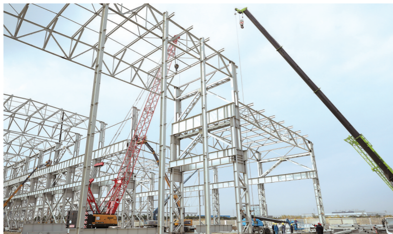
中重科技智能装备生产基地加紧施工
