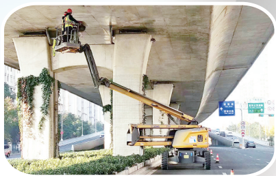
内环高架检测现场
