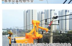
国网淮安供电公司在全省范围内率先实现列电机器人完成双回线路垂直列电线路接地环
