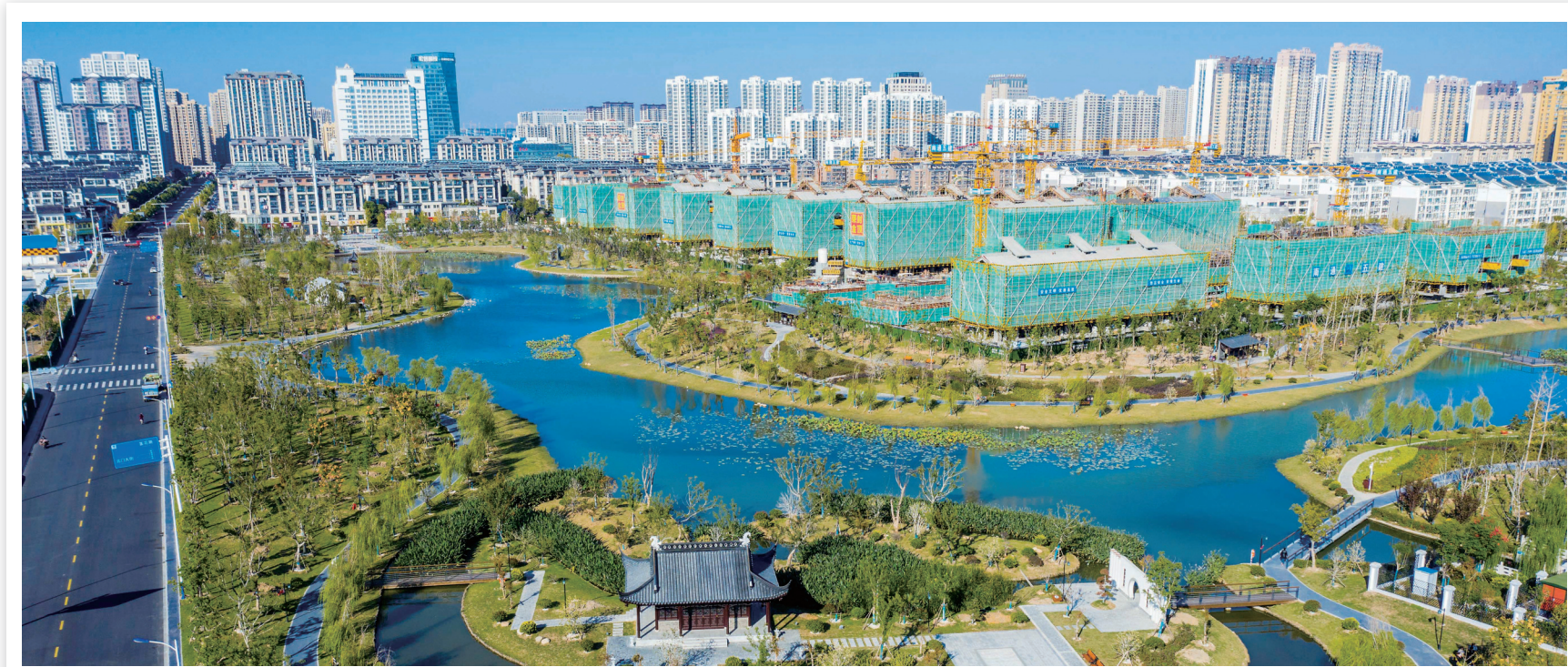
筑实百姓“安居梦” 淮安区坚持把安置房建设打造成民心工程,筑实百姓“安居梦”。图为昨日拍摄的建设中的荷湖安置小区工程,该小区建在整治一新的城市公园里,开门见绿、推窗观景、百米见园。 通讯员 朱天羽 刘武
