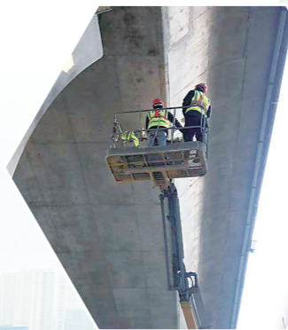
为内环高架“体检”
