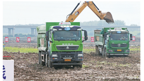
图为淮河入海水道二期工程开工动员会淮安分会场
