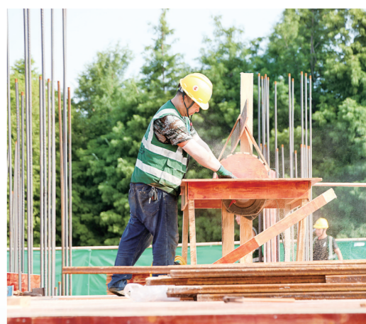
项目建设现场
