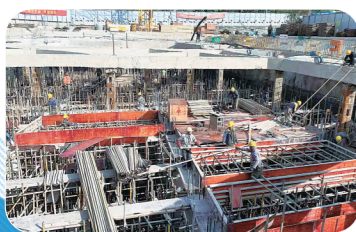
钵池山调蓄池施工现场
