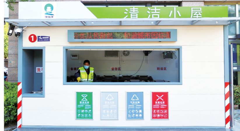
昨日，在清江浦区兴业国际小区垃圾分类收集点，工作人员在清洗垃圾桶。这个标准化的垃圾分类收集点具有投放后洗手、灭蝇灭蚊、臭氧消杀等功能。近年来，我市在部分小区开展生活垃圾“撤桶并点、定时定点”“四分法投放”试点工作，为居民创造一个舒适、优美的垃圾投放环境，逐步提升垃圾分类投放的参与率。 ■融媒体记者 王昊
