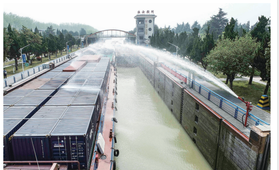
昨日,全省内河首套危化品运输专用通道消防系统在淮安船闸投入使用。该系统兼容抗溶性水成膜泡沫和自吸水两种灭火器,扬程可达44米,200米范围内实现远程控制或红外线热源自动捕捉,确保闸室水面洒水全覆盖。
