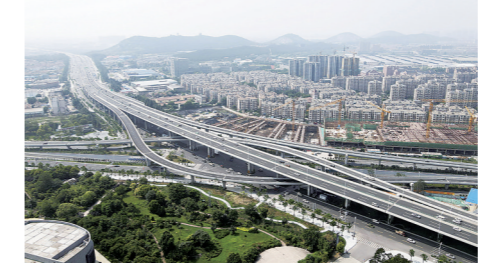
徐州市区迎宾大道高架快速路
