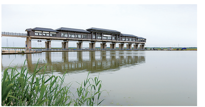
淮入江水道金湖东偏泓工程
