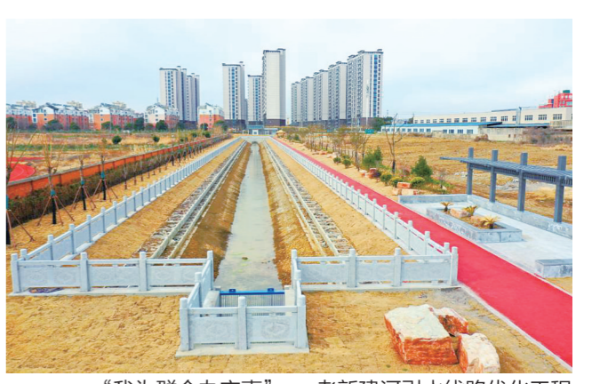
“我为群众办实事”——老新建河引水线路优化工程
